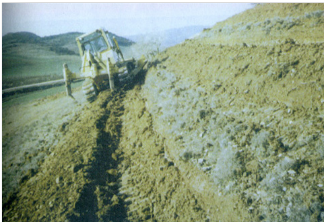
Машинска припрема на контурна бразда
